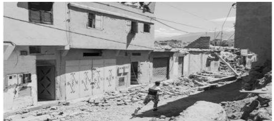
Un hombre corre cuando llega para recuperar artículos de su casa que resultó dañada por el terremoto, en la ciudad de Amizmiz, cerca de Marrakech, Marruecos, el domingo 10 de septiembre de 2023. AP - Mosa'ab Elshamy
