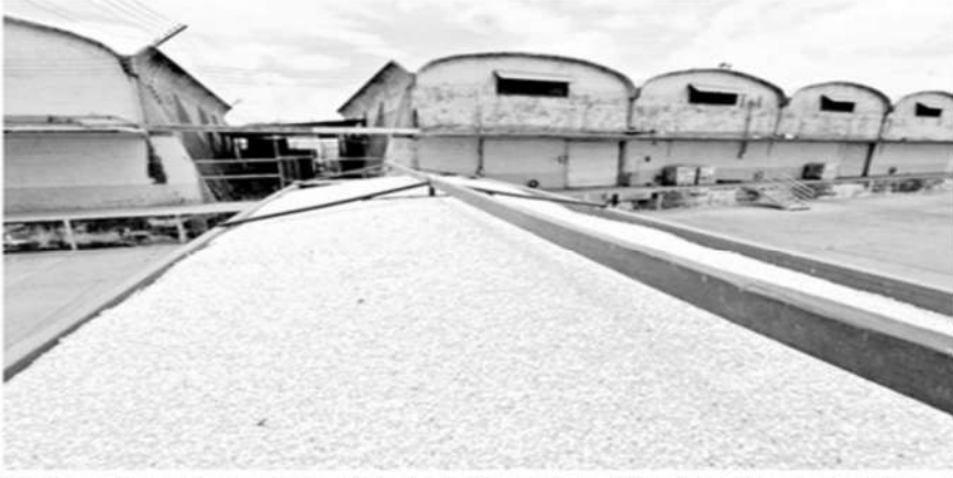
Bodega de maíz en el municipio de Navolato, Sinaloa, donde camiones descargan el grano. Foto Cristian Díaz / Archivo.
